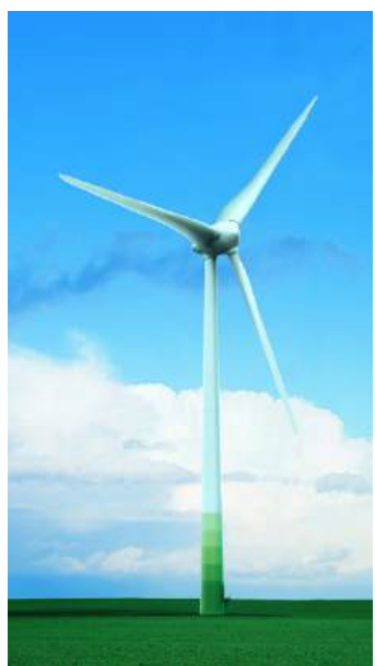
Ветроурбина типа Direct-Drive ENERCON-70
